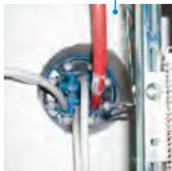
**Aeropuerto:** sellado de los cables que atraviesan una pared del centro de control de tráfico aéreo.
