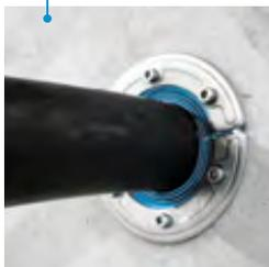
**Hospital:** cable eléctrico sellado y asegurado en el sótano.
